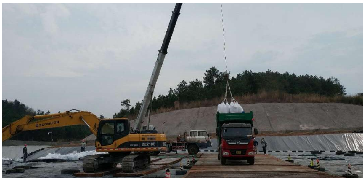
图 4.5-3 吊机吊装飞灰作业
